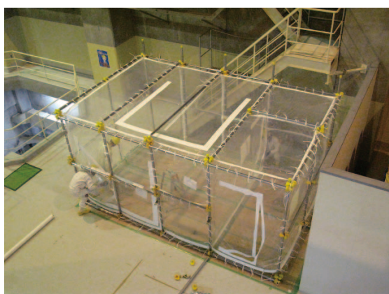
燃廃棟 2 階本船機材保管エリアに大型グリーンハウスを設置
