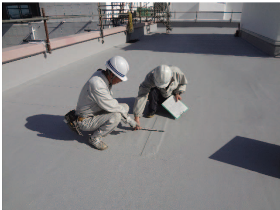
写真 1-1 保管建屋屋上防水層補修 （平成 27 年度）
