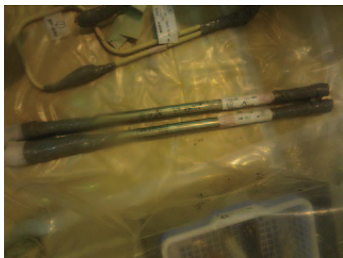
図-3.4.1 配管の先端養生
