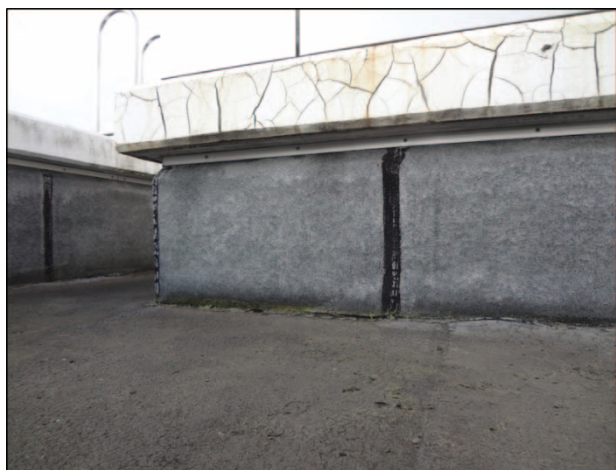
防水層の浮き及び破断状況
