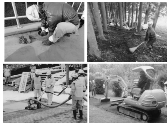
写真—3.1 除染作業の例
