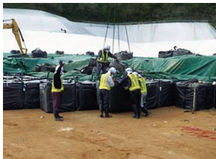
写真3 埋立作業の様子(環境省ホームページより) 3)
