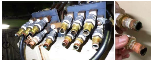
図 5. 腐食していた分析電磁石側継ぎ手
