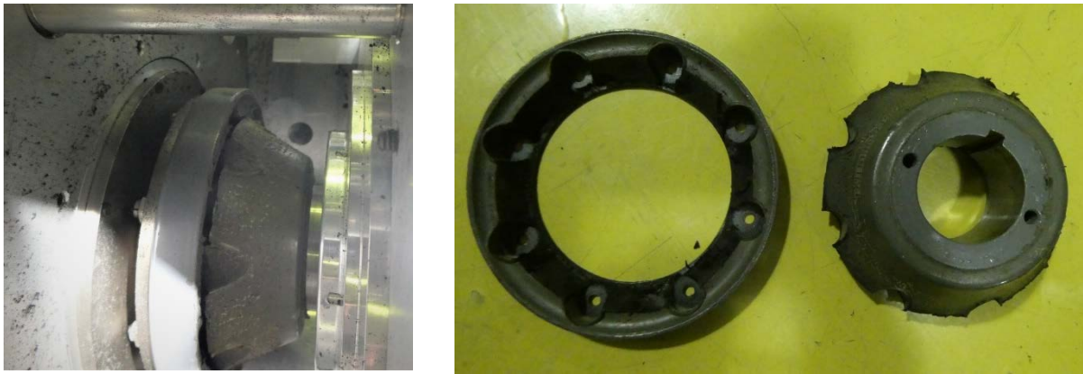
図5 破断したロータリーシャフトのカップリング
