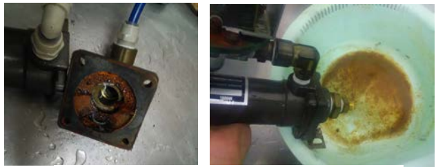
図5 熱交換器内部に発生した錆
