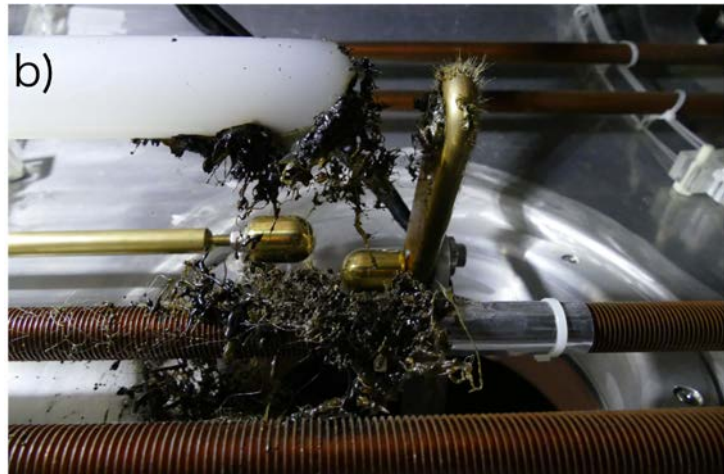
図3 RFトランスと焼損した支柱
