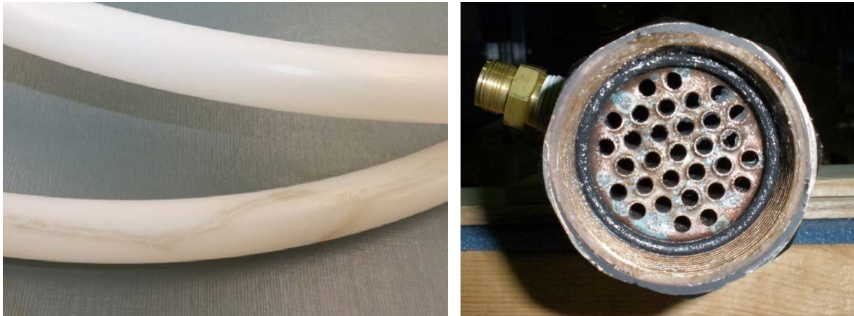
図 3 フロリナート配管についての放電痕（左）熱交換器内部の様子（右）
