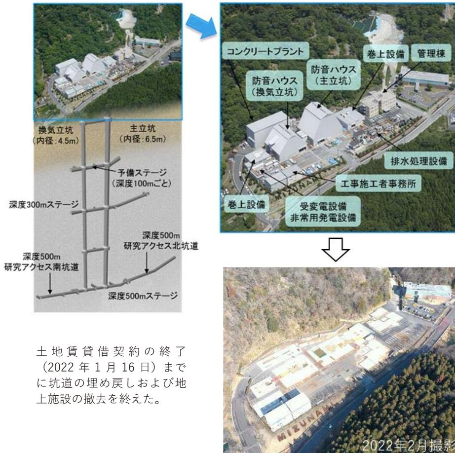
図1-2 瑞浪超深地層研究所の施設概要
