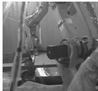
レーザー切断装置による溶断作業
