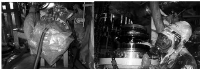
重水循環ポンプの分解点検作業
