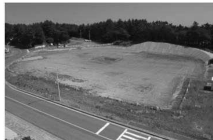
敷地整備後(H19.9.3)
