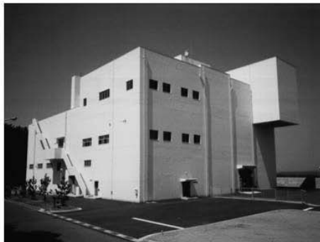
解体分別保管棟
