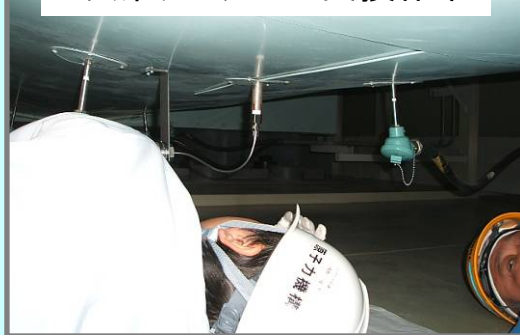
2次系タンクCLD交換作業
