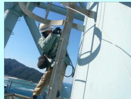
排気筒外面外観点検
