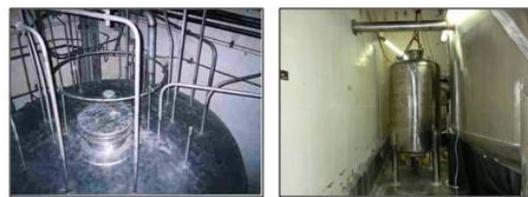
LV-1廻り配管類撤去 廃液貯槽LV-7撤去(実施済)
