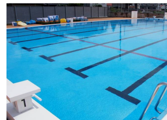
除染後のプール(検出限界以下)
