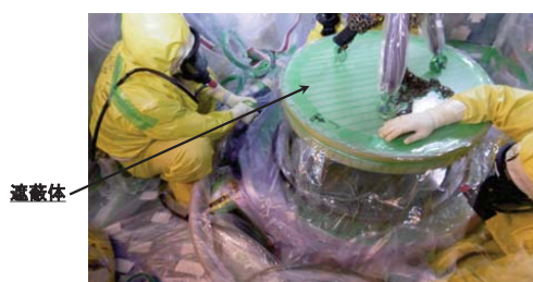
1次冷却設備のガス循環機（HGC）上部ケーシング ガスケット交換作業の様子
