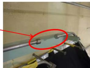
溶液燃料移送配管を切断
