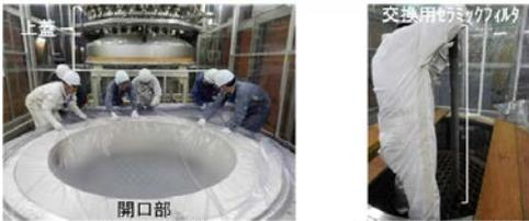
①上蓋開口作業      ②セラミックフィルタ交換作業
