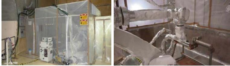
原子炉冷却材浄化系の配管の二次切断にレーザーを適用
