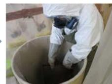
大型汚染機器(圧力放出槽)解体
