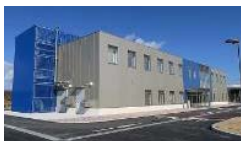
廃炉国際共同研究センター (国際共同研究棟)
