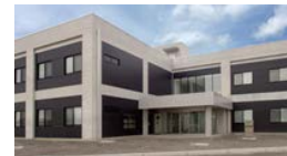
福島環境安全センター (福島県環境創造センター内)
