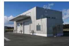
多目的試験棟の外観
