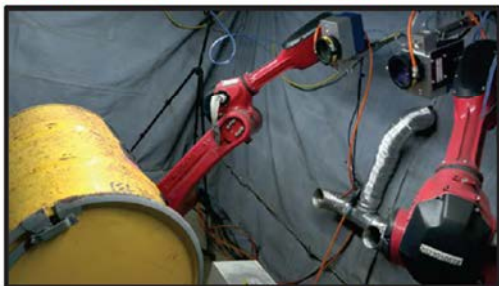
レーザー除錆中の様子
