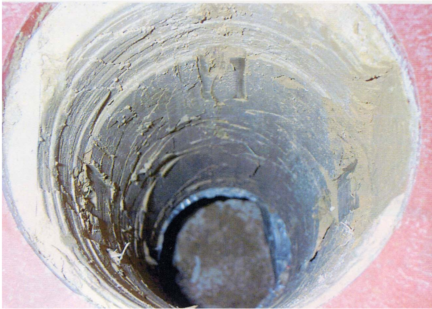
図 4-1 せん断破壊によるうろこ状の破壊形状 14)
