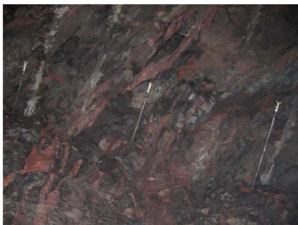
図 3.3-16 注入箇所切羽面<sup>27)</sup>
