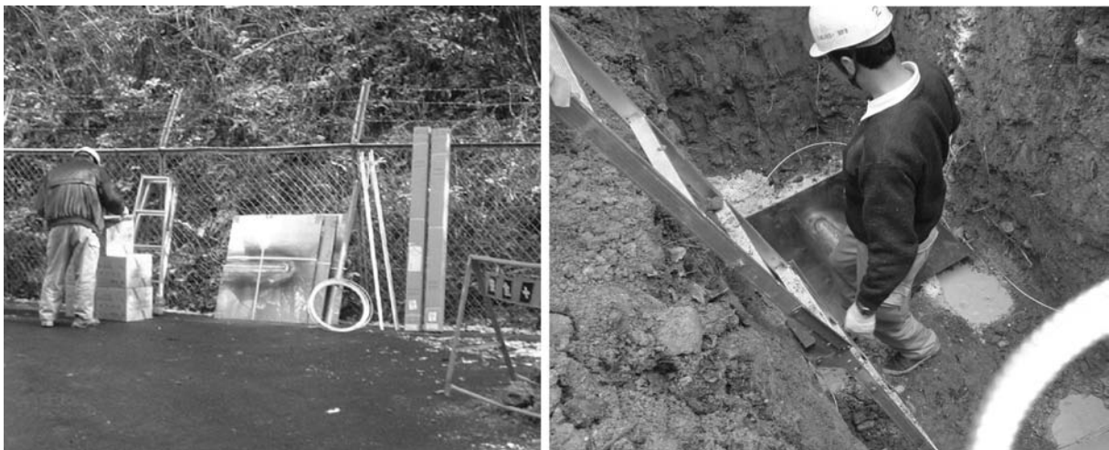
写真 1 2004 年 2 月の作業写真 (左が設置電極材料 (銅板および 1.8m 長の鉄心入銅棒電極)、右が S 電極設置時で、銅版を接地抵抗低減剤とともに埋めているところ)
