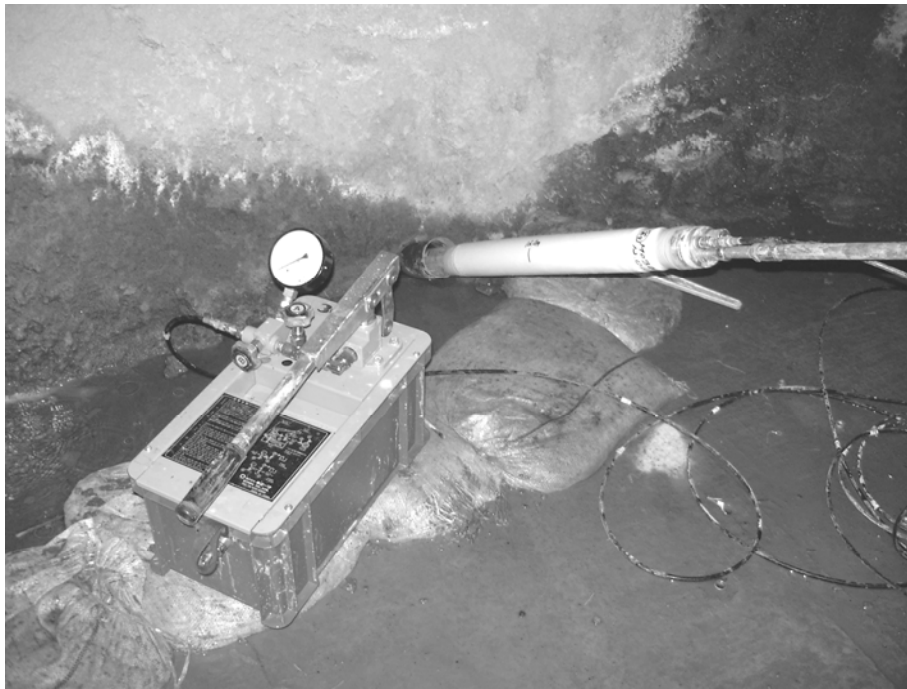
図 4.2 可塑性のチューブによって被覆した型取パッカーの挿入
