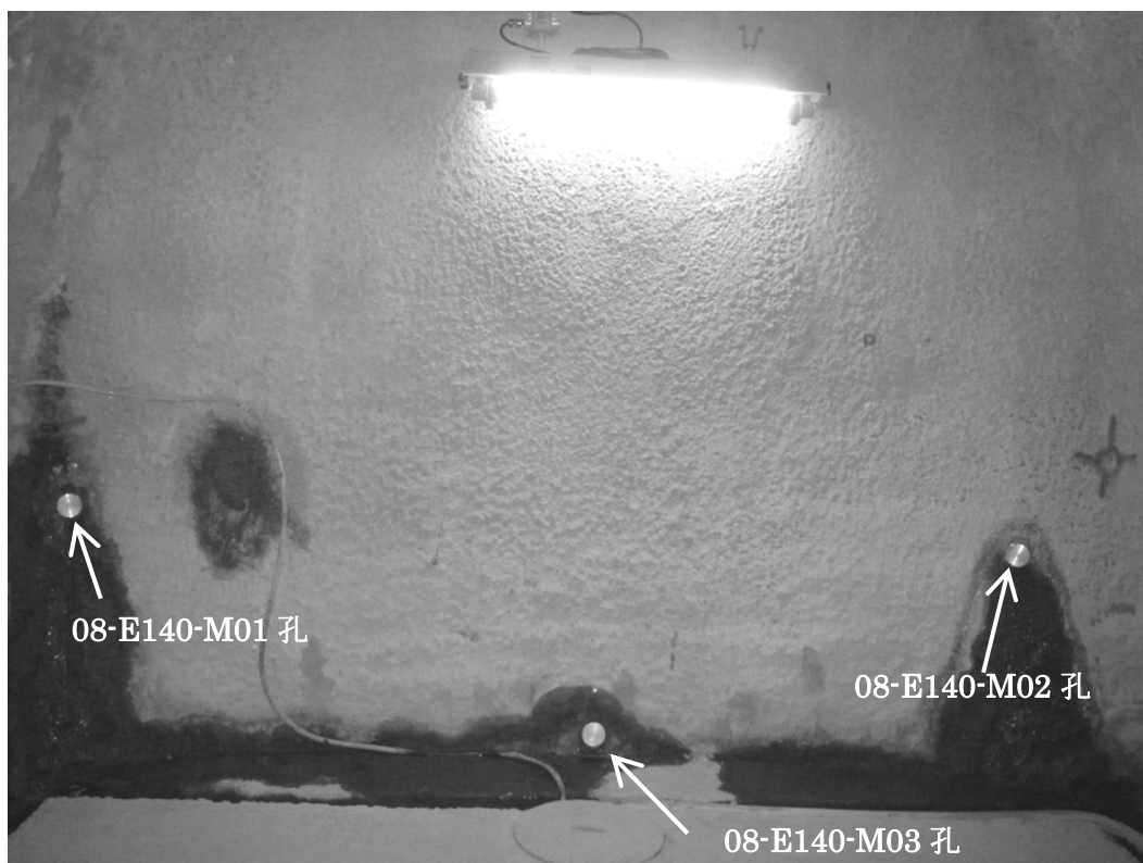
図 2.2 ボーリング掘削完了状況
