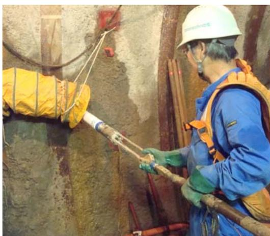
図 4.2 可塑性のチューブによって被覆した型取パッカーの挿入
