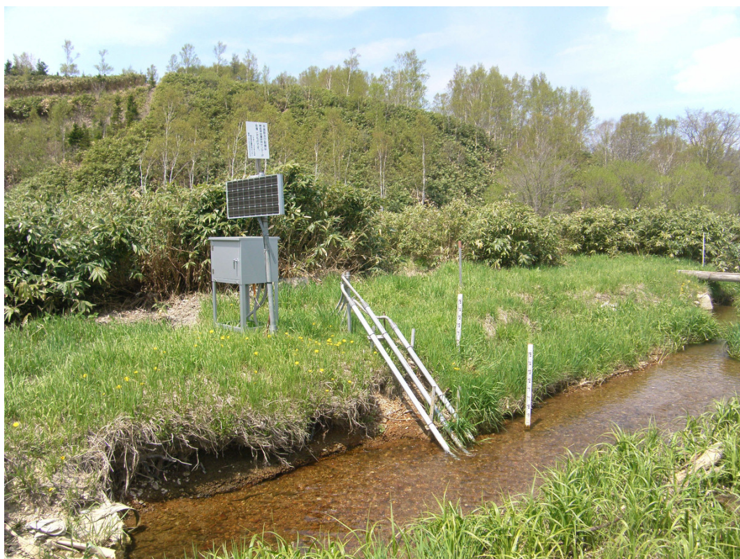
写真 4.3 河川流量観測システム設置状況 (P-4 地点)
