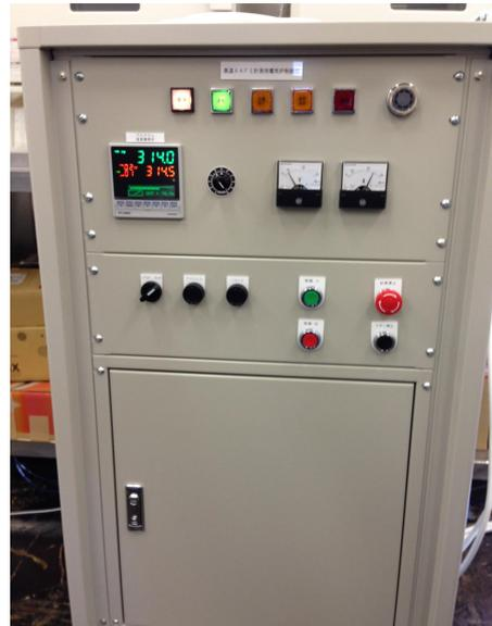
写真 4-2 電気炉温度調節ユニット
