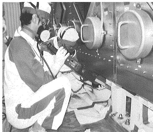
図 3.2 架台切断風景
