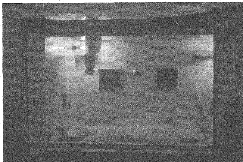
Photo 4.1.2 S Eセル内装機器解体撤去後
