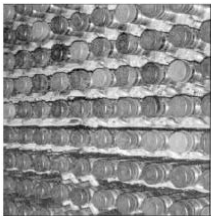
写真A - 2 セルナボーダ原子力発電所1号機のエンドフィッティングのプラグ部 〔出典：CONVEX-3 (2005) Exercise Report 3) 〕
