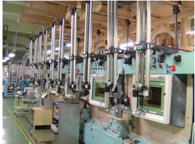
写真 3.1 分析所 1 階 高放射性試料分析室
