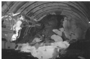
トンネル施工時の様子
