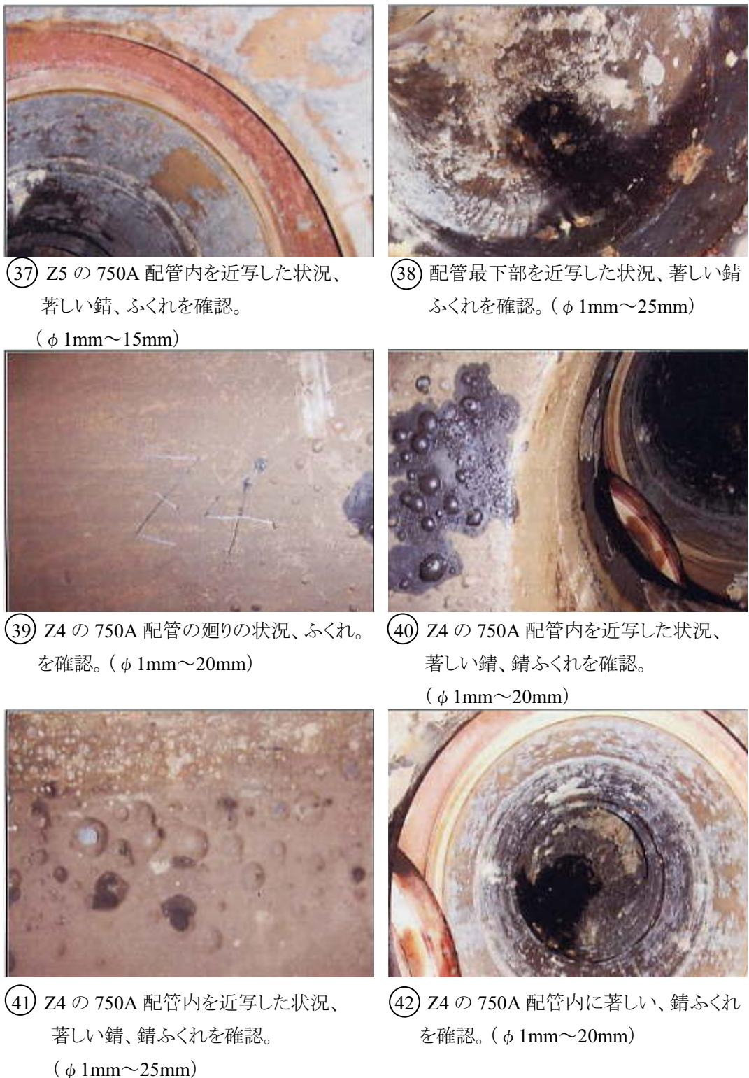
Fig. 9 給水ヘッダ配管内部撮影画像 (2/3)
