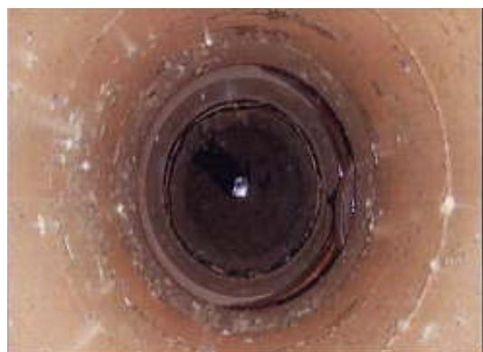
②6 Z1 の 750A 配管全面に著しいふくれを確認。( $\phi$  1mm～30mm)
