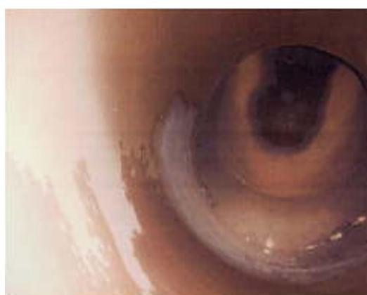
オ) X9 の 450A 配管内面の状態は比較的良いが、溶接線に鋸、手前にふくれが。確認。
