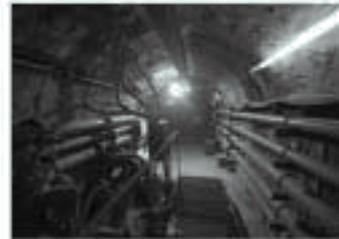
手掘り階段の排水設備 (配管、揚水ポンプ等)
