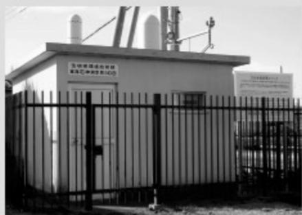
原子力施設周辺の放射能(線)を連続的に測定し、監視する設備。空間放射線量の測定器のほか、空気中のちりやヨウ素を捕集・測定する装置。風向きや風速も観測している。
