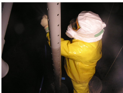
Photo. 6.1.3 DP タンク内部除染
