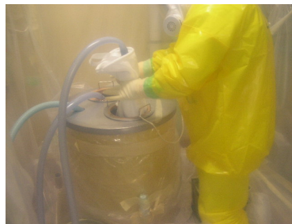
Photo. 6.1.2 水フィルタ交換作業
