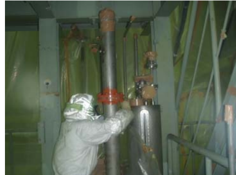
P C 解体
