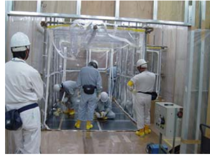
簡易ハウス設置
