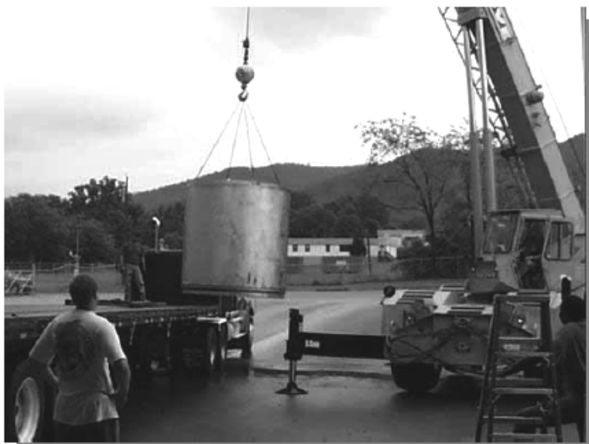
Fig. 2 使用済みイオン交換樹脂の専用収納容器
