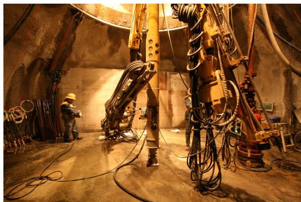
図 4.7-2 シャフトジャンボによる注入孔の削孔状況
