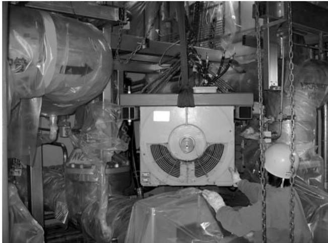
電動機搬出作業
