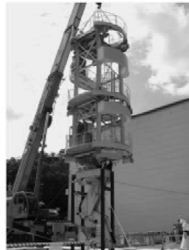
スcaフォード(立坑内での 作業用吊り足場:換気立坑)
