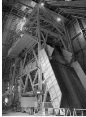
櫓設備(換気立坑)
