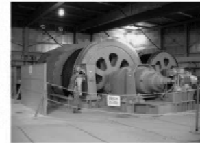
巻上設備(主立坑)
