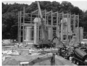
コンクリートプラント
