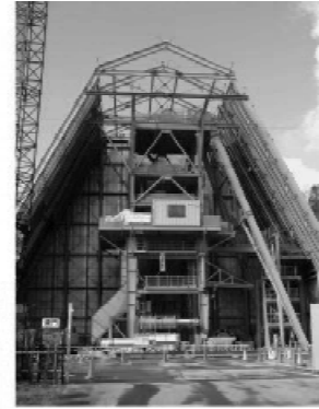
櫓設備(主立坑の 防音ハウス組立作業)
