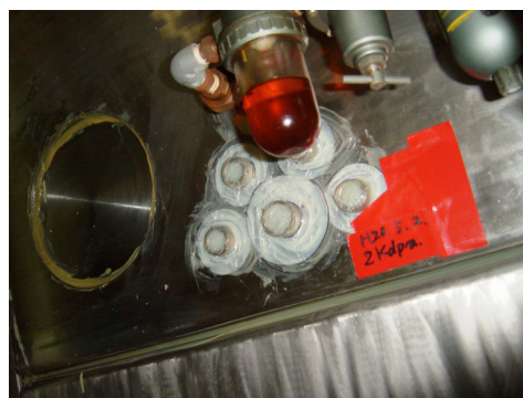
汚染検出箇所 (F-103)
