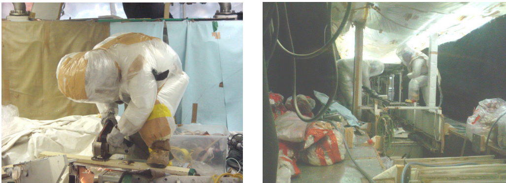
図 3.10 受払搬送設備の撤去解体作業
