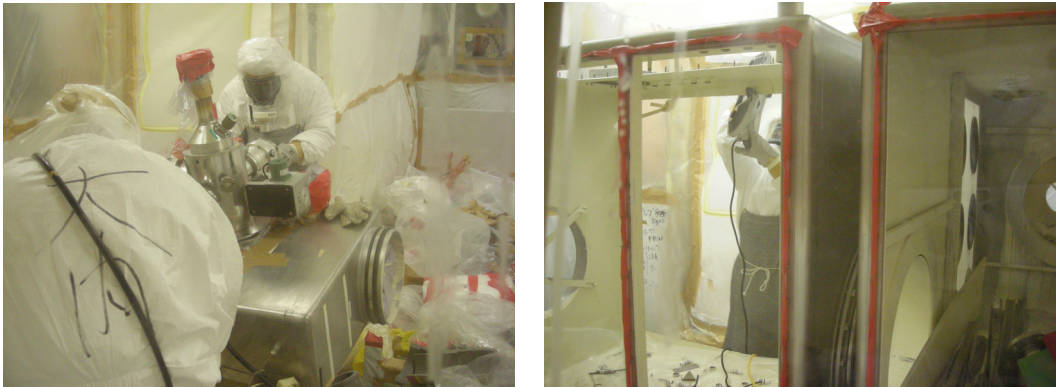
GB 内でのオープンポートボックス解体
