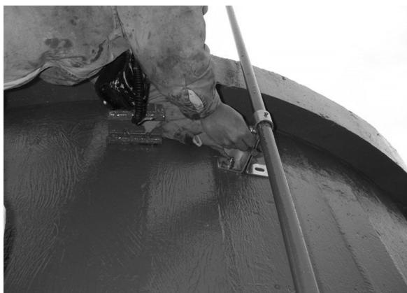
Photo. 5.17 避雷設備金具更新(排気筒)
