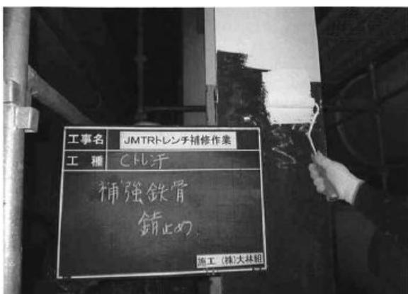
Photo. 5.31 補強鉄骨下塗り (トレンチ)
