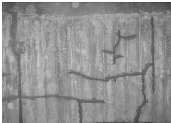
Photo. 5.14 内部充填剤埋め戻し後(排気筒)
