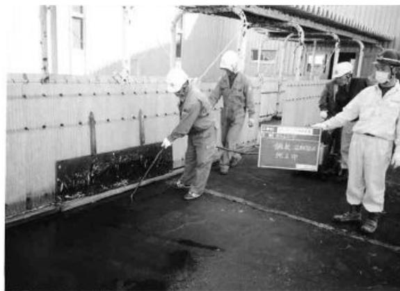
Photo. 5.26 アスファルト舗装工事(トレンチ)
