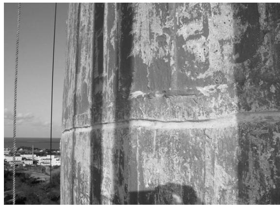
Photo. 5.6 ひび割れ U カット後(排気筒)
