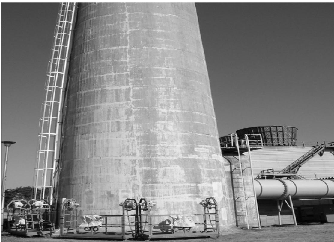
Photo. 5.33 筒体下部補修前(排気筒)
