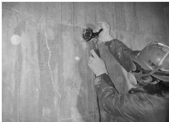
Photo. 5.12 内部ひび割れ Uカット (排気筒)
