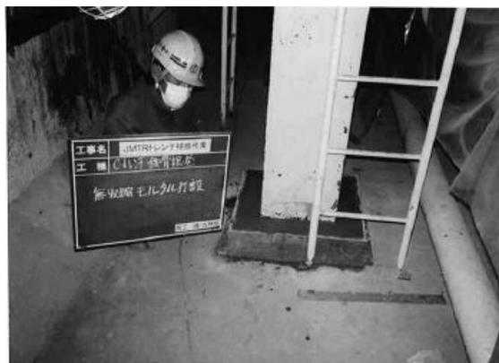
Photo. 5.30 補強鉄骨根巻き
