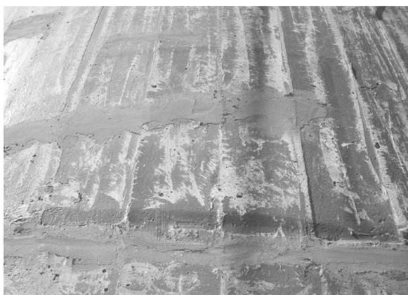
Photo. 5.10 充填剤埋め戻し後 (排気筒)
