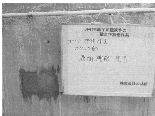
Photo. 3.14 コア孔補修(表面仕上げ)
