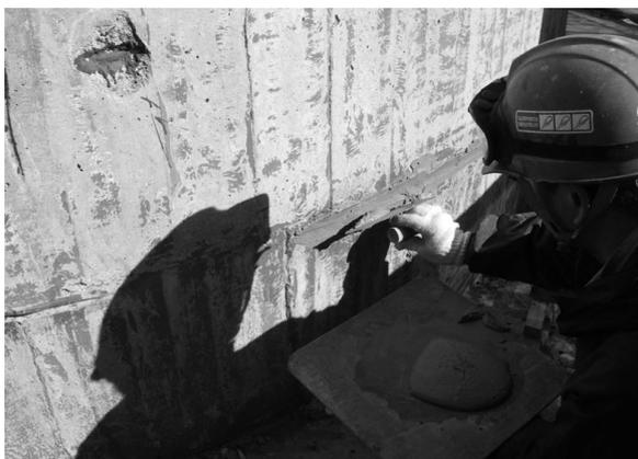
Photo. 5.7 充填剤埋め戻し(排気筒)
