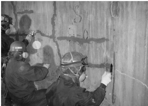
Photo. 5.13 内部充填剤埋め戻し(排気筒)
