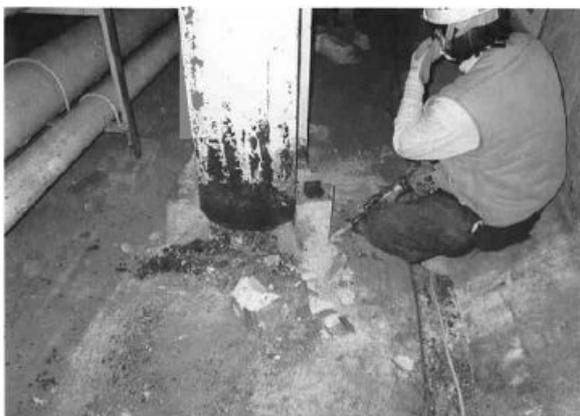
Photo. 5.29 既存補強鉄骨根巻き
