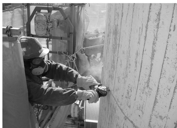
Photo. 5.5 ひび割れ U カット(排気筒)
