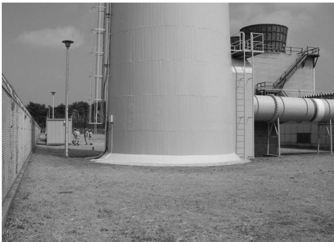
Photo. 5.34 筒体下部補修後(排気筒)
