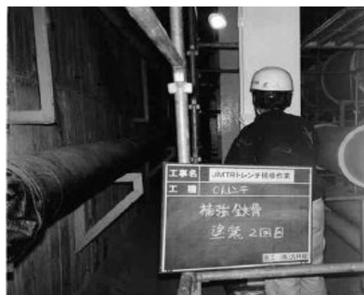
Photo. 5.32 補強鉄骨上塗り (トレンチ)
