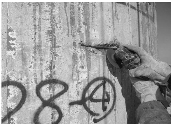
Photo. 5.9 鉄筋さびの除去 (排気筒)
