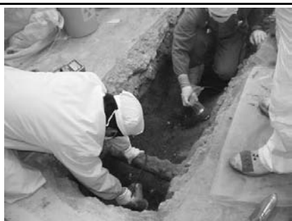
埋設配管の撤去後の汚染測定
