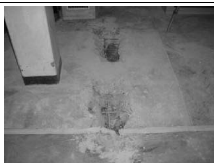
A H C F 配管の調査
