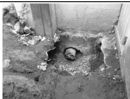
A H C F 配管の撤去跡 (屋外)
