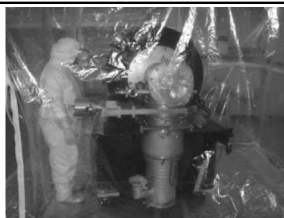
機器の解体撤去
