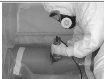
排気ダクトの撤去
