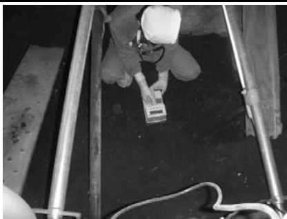
排水柵撤去後の汚染測定 (屋外排水柵)
