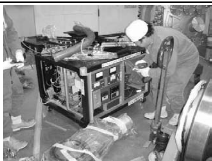
機器の解体撤去
