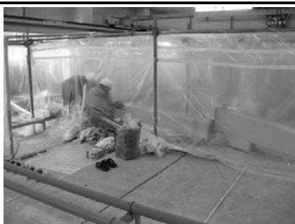
排気ダクト解体撤去 (屋内非管理区域)
