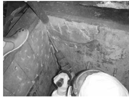
防水処理剤の撤去 (屋外排水柵)
