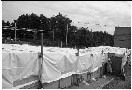
屋外埋設配管の撤去 (外観)
