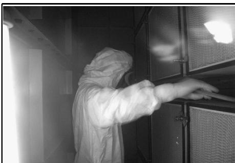
フィルタの撤去 (排風機室)
