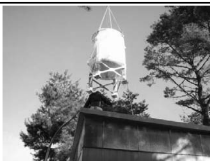
廃液貯槽の一括搬出 (廃液貯槽室)
