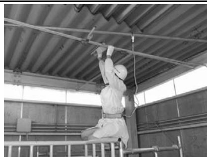
汚染検査 (廃液貯槽室)
