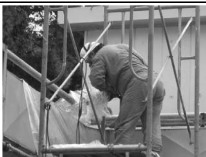
排気管(ベント管)解体撤去 (屋外)
