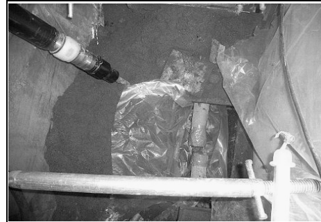
屋外埋設配管の撤去 (撤去作業)
