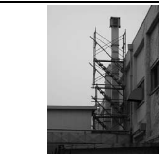
排気筒の解体撤去(フィルタチャンバ二次側) (屋外)
