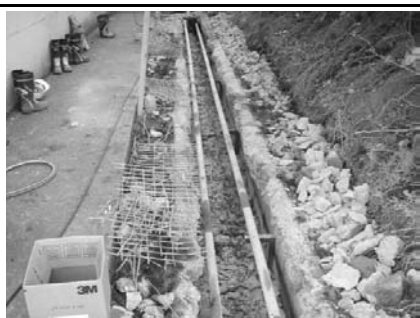
ホット配管の撤去 (屋外)
