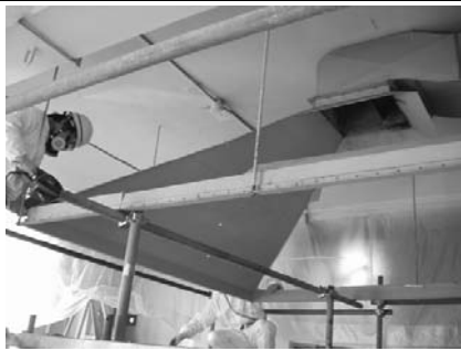
キャノピーフードの解体
