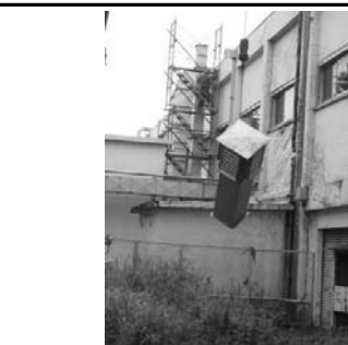
排気筒の解体撤去(フィルタチャンバ二次側) (屋外)
