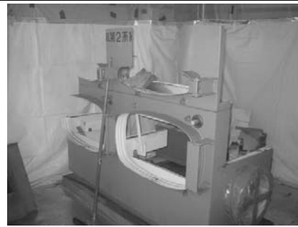
フィルタユニットの解体 (排風機室)
