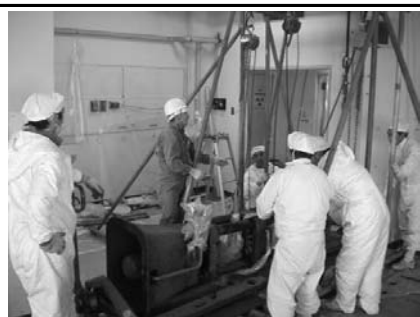
プレス機の解体
