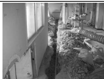
埋設配管の撤去
