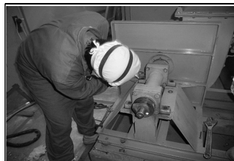
排風機の解体 (排風機室)
