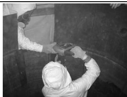
廃液貯槽タンクの解体 (廃液貯槽室)
