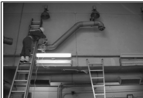
排気管の解体撤去 (10号室)
