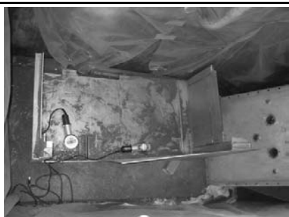
中継用集水タンクの解体 (廃液貯槽室)
