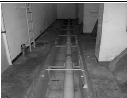
ホット配管の撤去 (屋内非管理区域)
