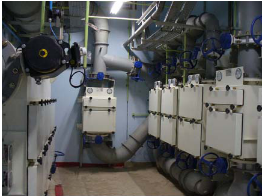
Fig. 5-7 管理区域の排気フィルター
