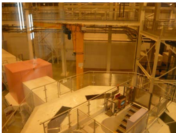
31 建設中の 2 ed Target station
