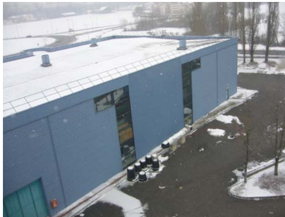
62 この建屋から地下100mへ加速器等を搬入した。
