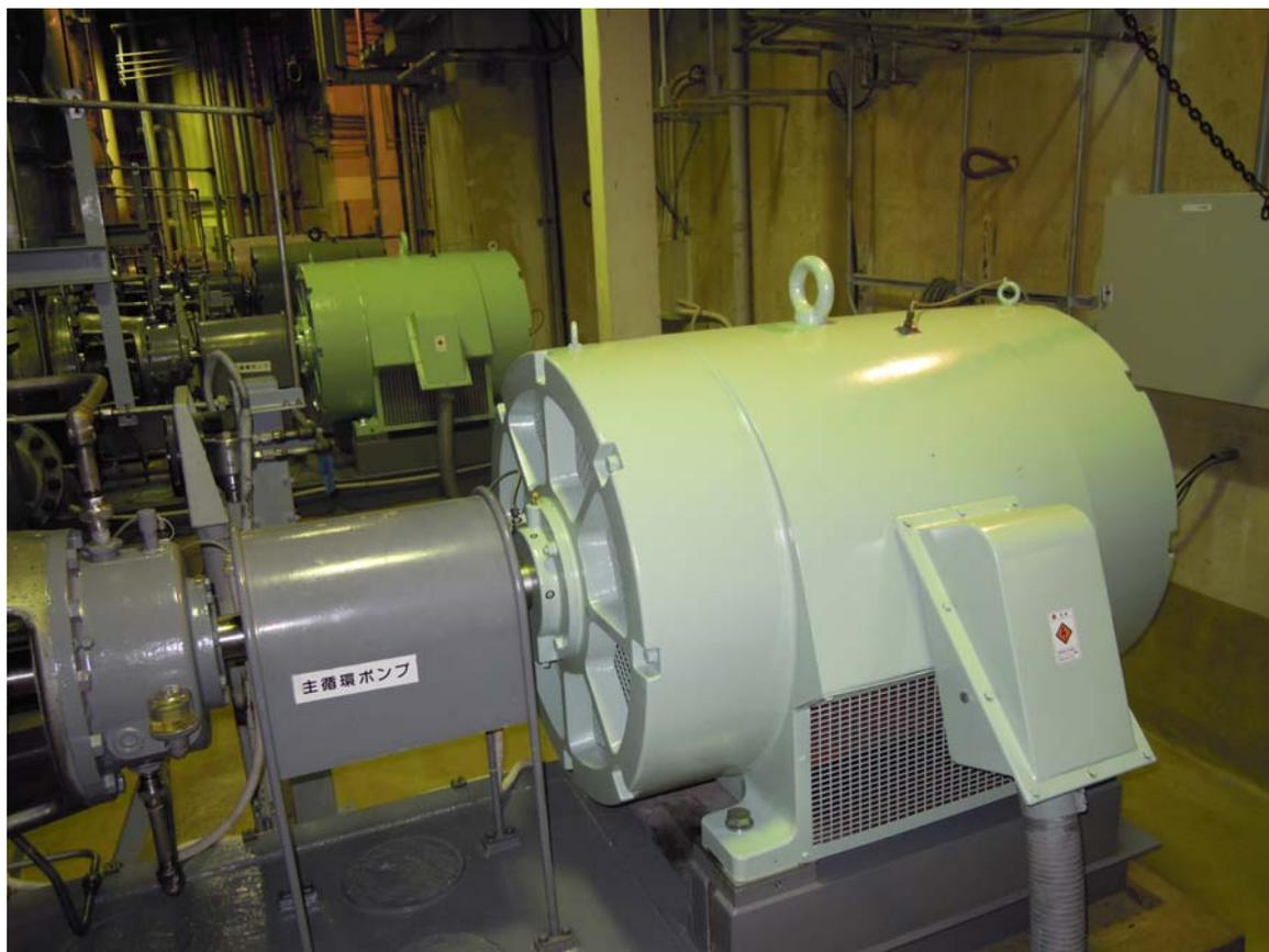
Photo. 1 主循環ポンプの電動機
