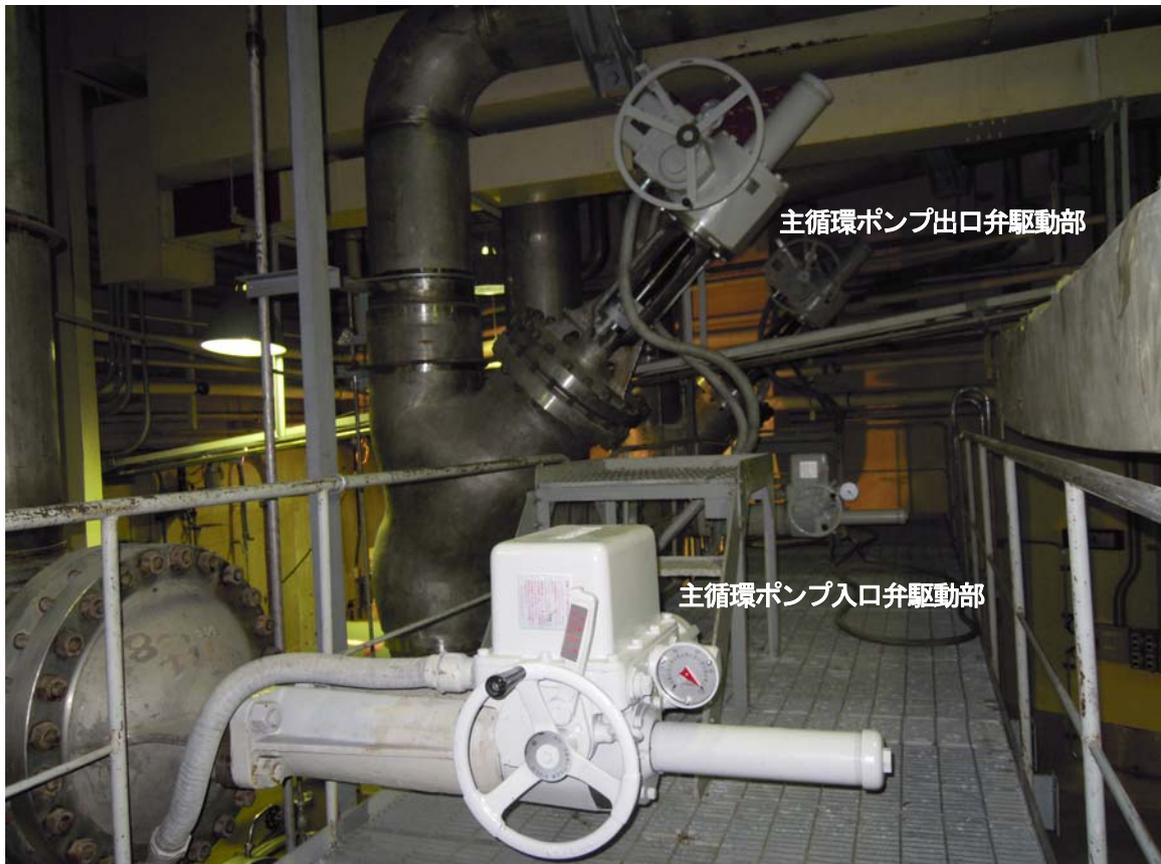
Photo. 4 主循環ポンプ入口弁駆動部及び主循環ポンプ出口弁駆動部
