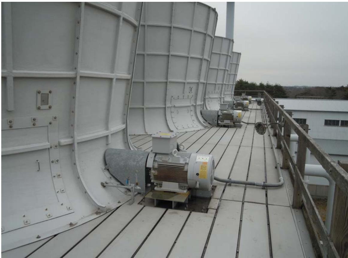
Photo. 10 冷却塔ファンの電動機
