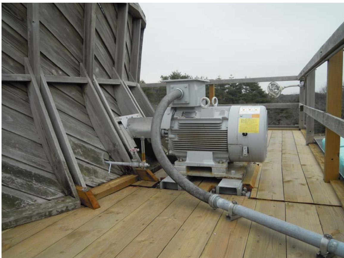
Photo. 15 冷却塔ファンの電動機
