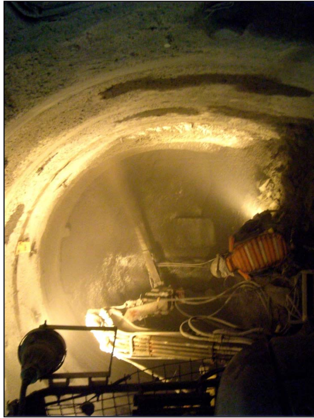
低アルカリ性コンクリート材料の吹付け状況 (140m調査坑道の例)
