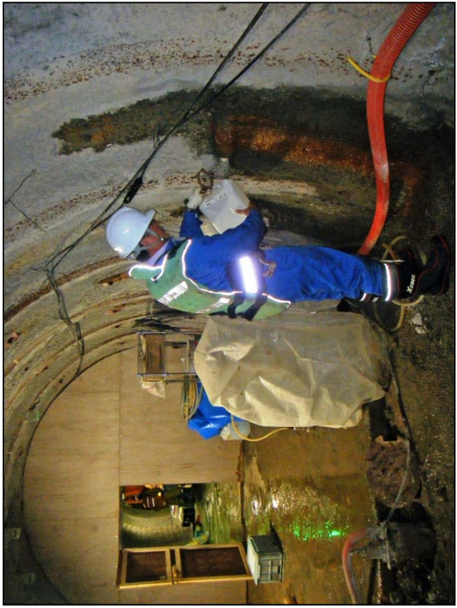
地下水採取の様子 (250m調査坑道)
