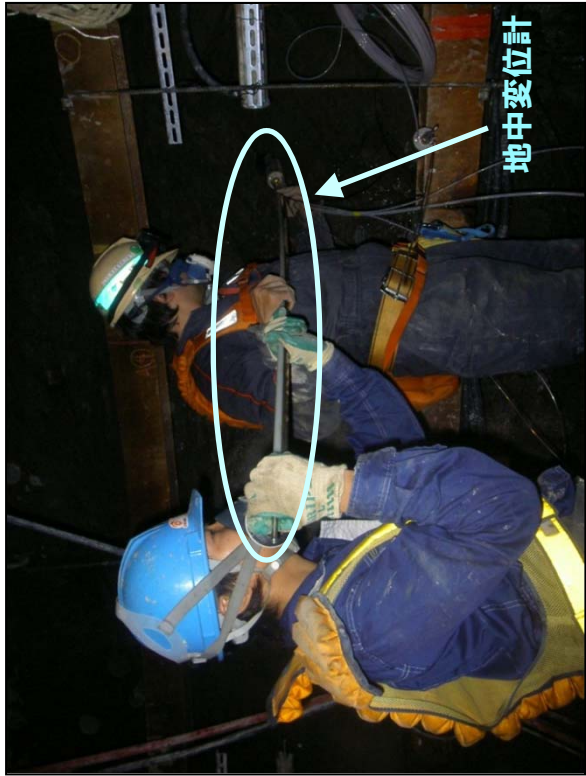
地中変位計設置状況 (東立坑深度160m)
