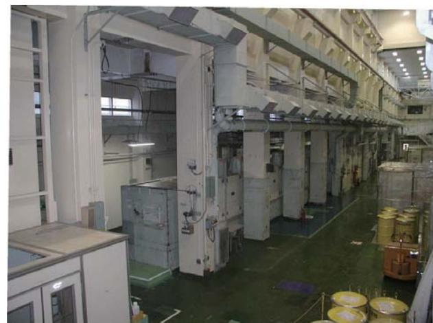
Photo. 4.2 附帯設備解体後の鉛セル全体写真
