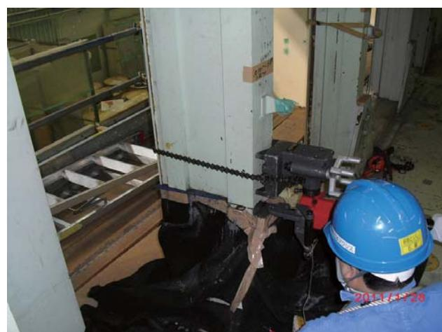
Photo. 4.3 背面扉の支柱切断作業
