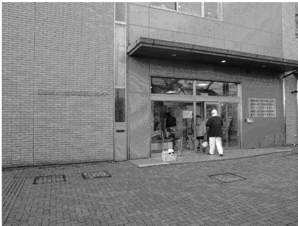
写真 5. 福島オフサイトセンター（大熊町）の状況
