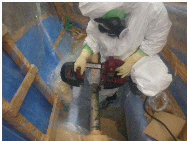
写真 2.3.2-2 廃液輸送管切断作業
