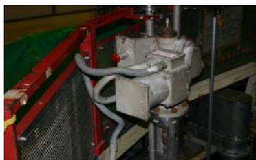
○炉プール連通弁等の駆動部(電磁コイル)の更新
