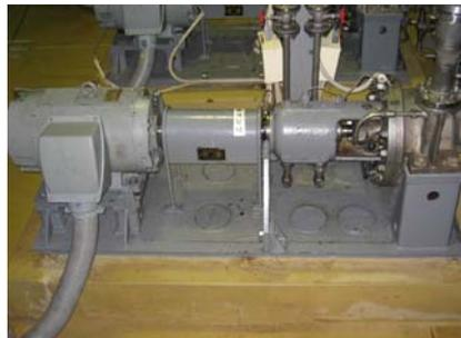
○充填ポンプ(電動機を含む)2台の更新
