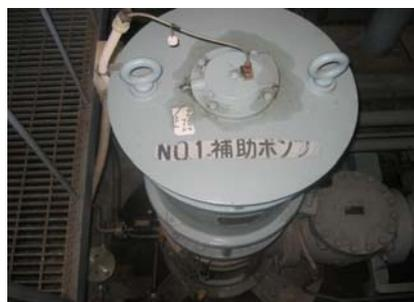
○ 循環ポンプ (電動機を含む) 4 台の更新
