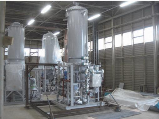
Photo. 5.3 純水装置 3 (脱気純水系)
