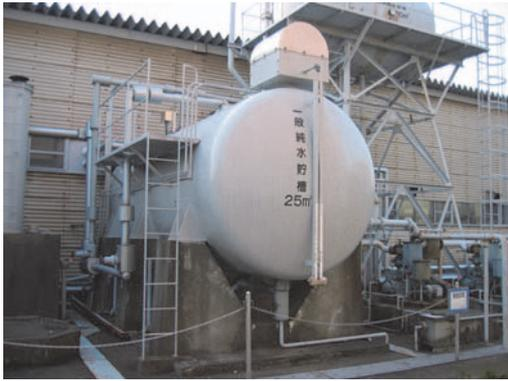
Photo. 2.1 一般純水貯槽解体前
