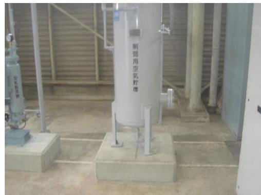
Photo. 7.11 制御用空気貯槽
