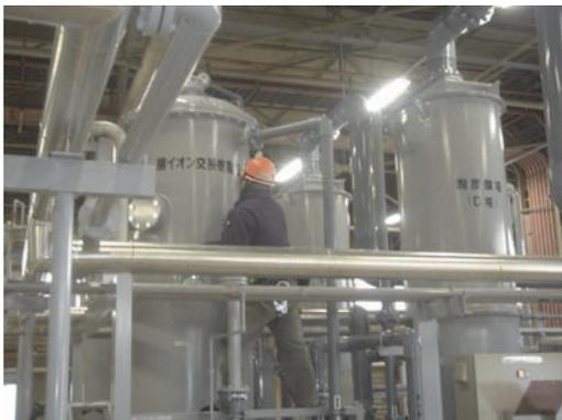
Photo. 6.15 純水装置 7 (一般純水系)
