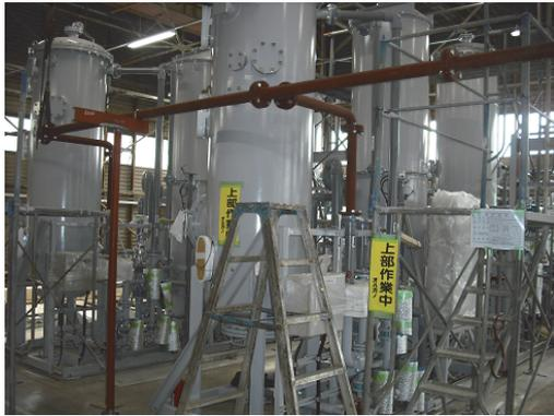
Photo. 6.11 純水装置 3 (一般純水系)
