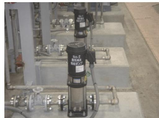
Photo. 5.8 脱気純水補給ポンプ
