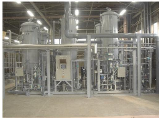
Photo. 6.16 純水装置 8 (一般純水系)
