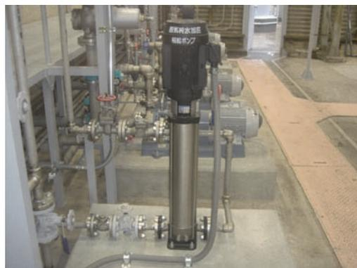
Photo. 5.7 脱気純水加圧補給ポンプ
