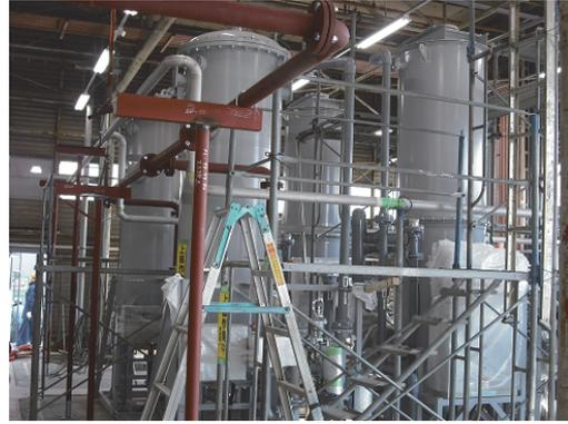
Photo. 6.12 純水装置 4 (一般純水系)
