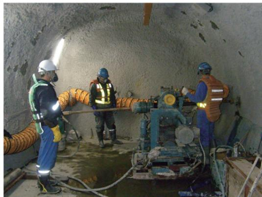
初期地圧測定のためのボーリング掘削の様子
