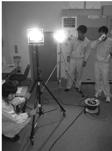
第6.3.2図 仮設照明
