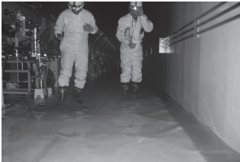
図 2.1-1 リニアック施設の被害状況(加速器トンネル内地下水流入)
