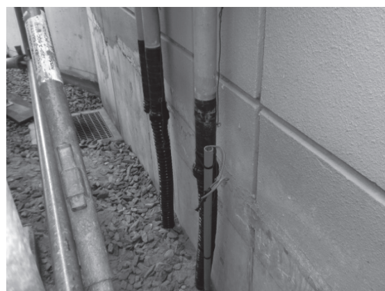
図 5.4-3 ケーブル用埋設管の脱落 (3 GeVシンクロトロン施設)
