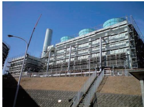
第2.1.1図 原子炉建家、排気塔及び冷却塔の補修（足場組立）
