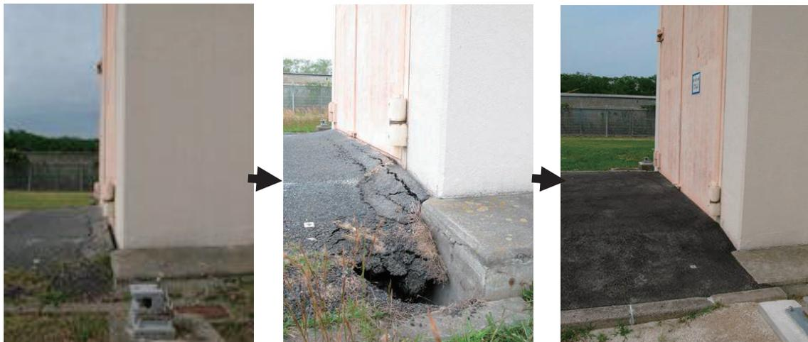
第 2.6.5 図 トラック出入口の段差とその後の陥没及び補修後の状況
