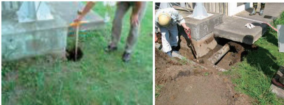
第 2.6.4 図 排気筒付近の陥没と試掘調査の状況
