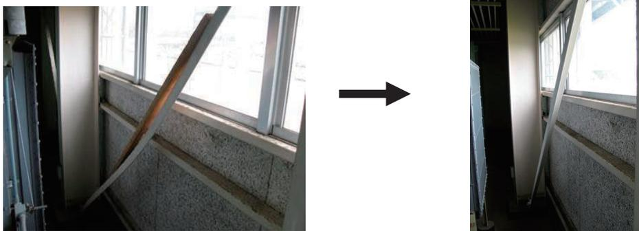
第 2.6.1 図 機械室建家の変形した筋交い（鉄骨）の補修前後の状況
