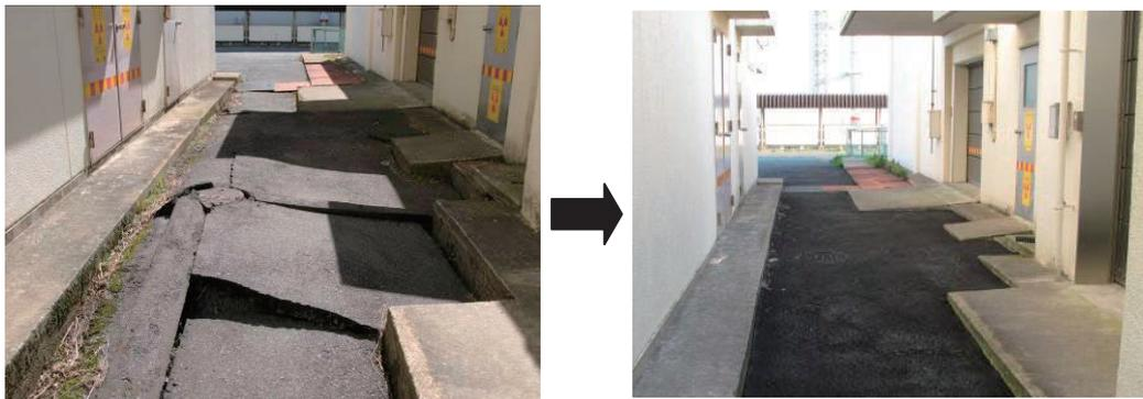
第 2.5.5 図 RI 製造棟周辺地盤沈下の状況と補修後の状況
