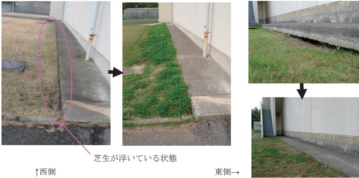
第 2.6.3 図 建家周り地盤沈下の補修前後の状況
