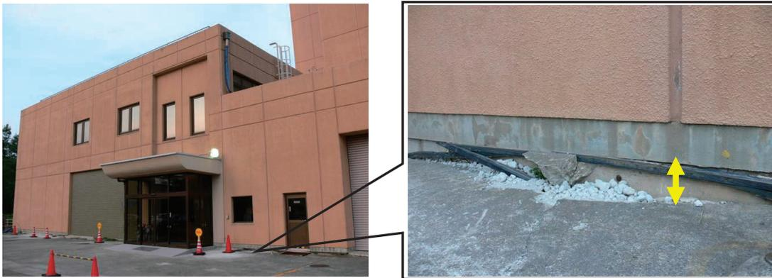
第2.4.2図 左：建家に対して玄関前コンクリート路面が約15 cm沈下した
