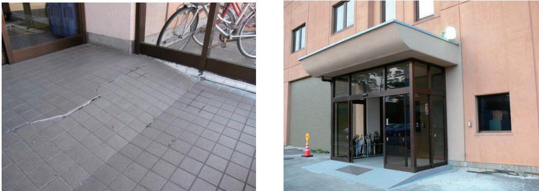
第 2.4.1 図 左：地盤沈下によりタイルが破損して玄関自動ドアが浮いている
