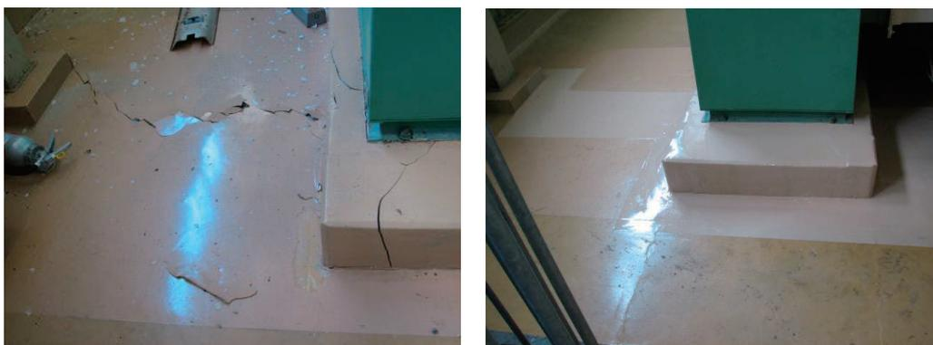
第 2.3.3 図 機械棟排風機室床面の損傷及び復旧状況
