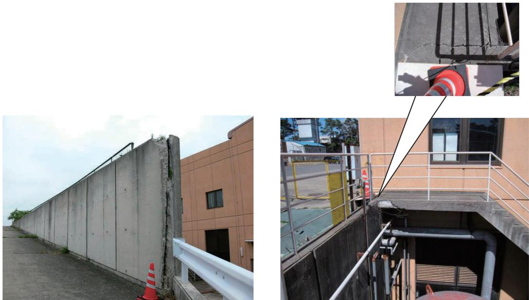
第2.4.3図 左：擁壁の継ぎ目部分のひび割れたコンクリート片を取り崩した
