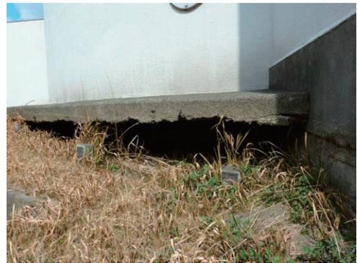
第 2.3.1 図 原子炉建家周辺における地盤沈下の様子
